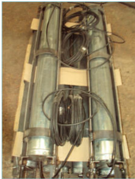
**Рис.3 Анодные заземлители глубинного размещения.**
