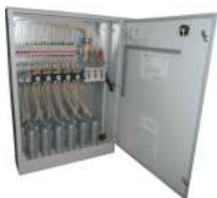
Конденсаторные установки 0,4–0,69 кВ
